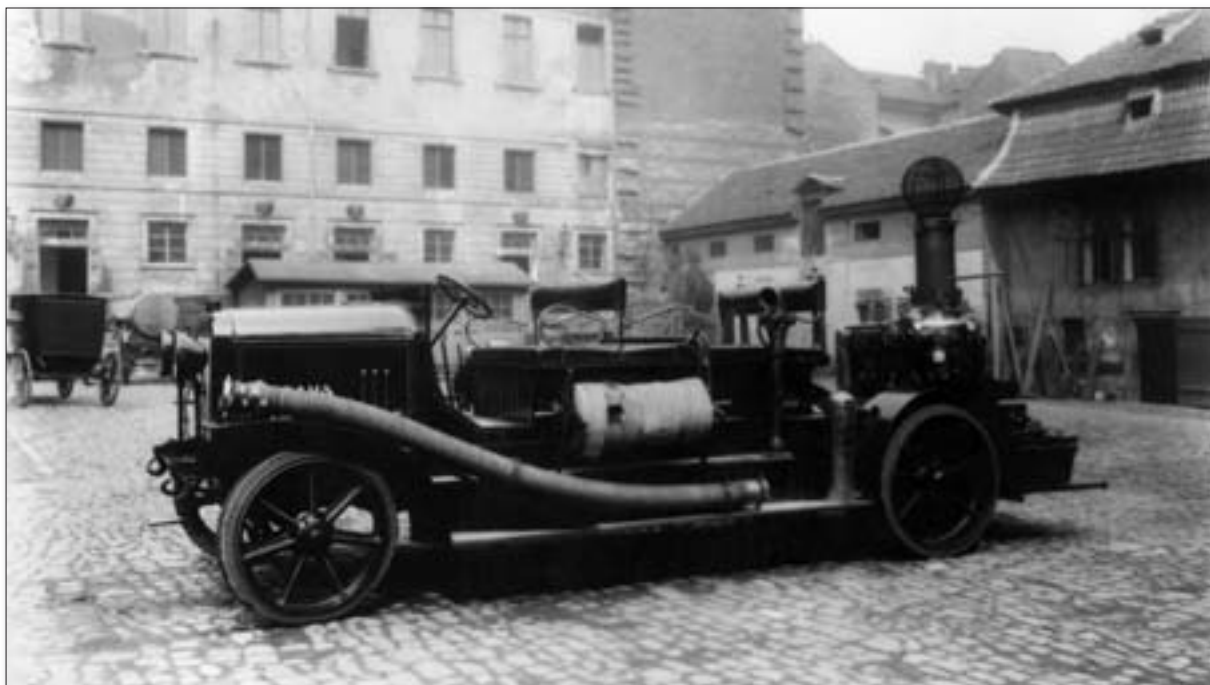
Dvouválcová parní stříkačka firmy Smekal na podvozku Berliet 35 HP z roku 1923
